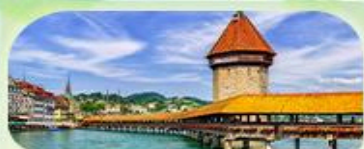
สะพานไมซ์าเปิล
