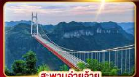
สะพานอ้ายจ้าย
