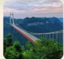
สะพานอ้ายจ้าย
